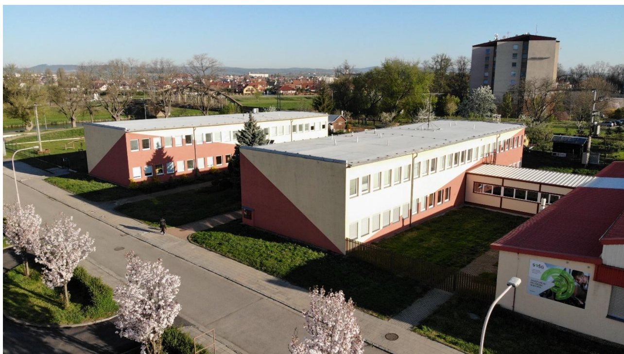
Obrázek 1: Budova odloučeného pracoviště v Uherském Hradišti
