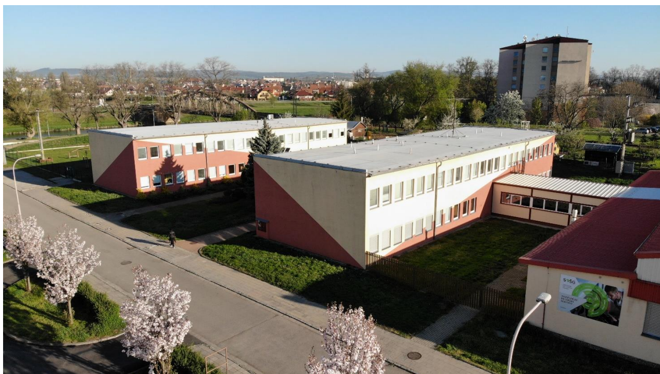
Obrázek 1: Budova odloučeného pracoviště v Uherském Hradišti
